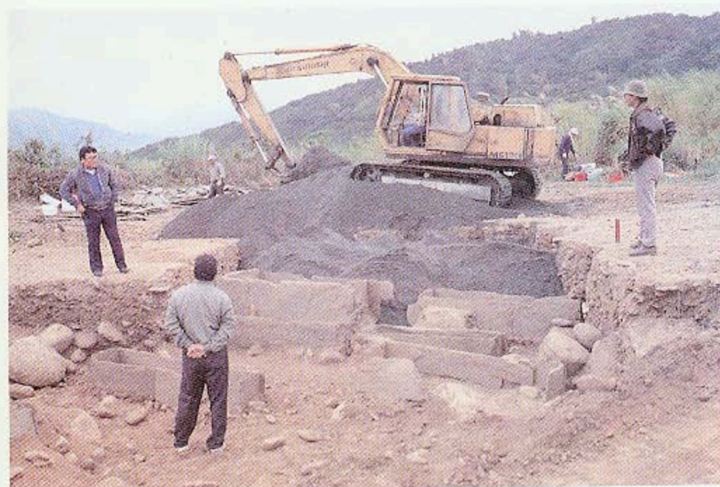
圖版三b 被破壞區經處理後先以河砂回填，河砂上再覆以天然級配。
