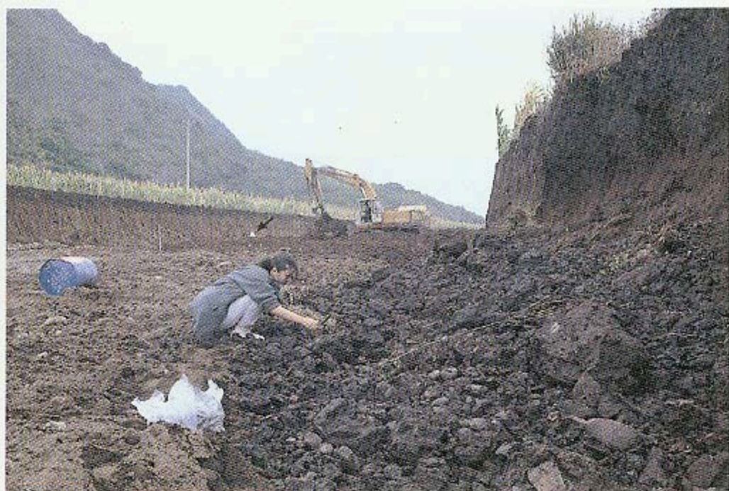
圖版一a TH I 遺址上道路施工情形及石板棺出土位置
