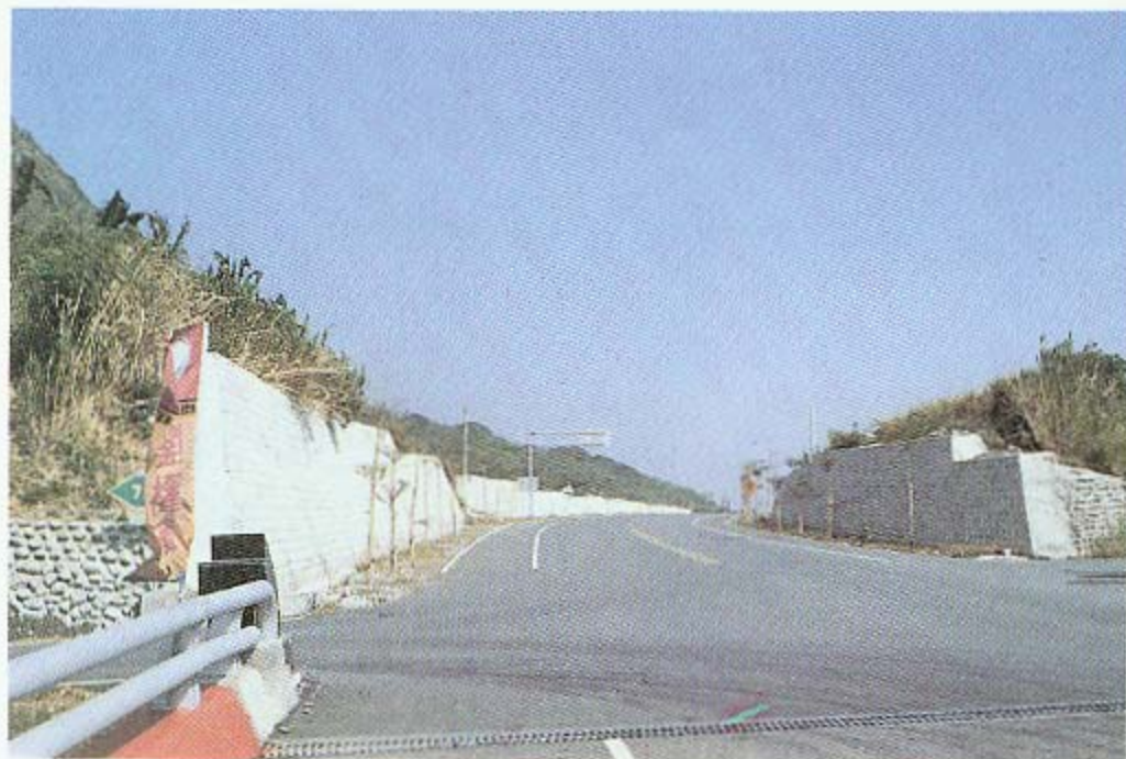
圖版 1b 新東河橋完工後之北引道現況
