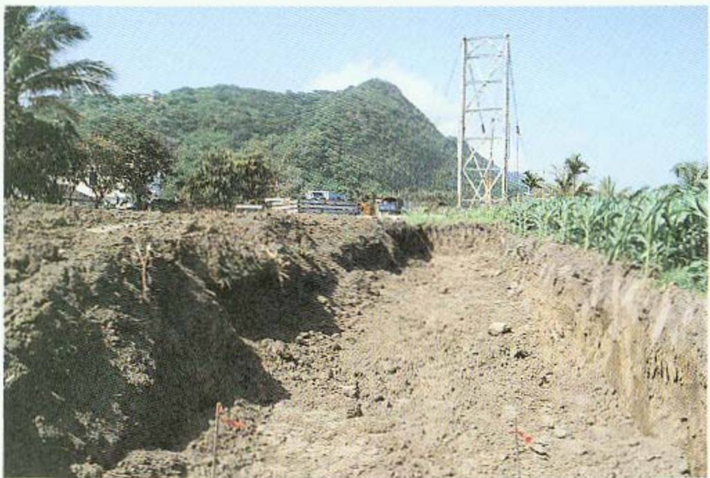
圖版二b 工程單位在東河橋新建工程南引道挖開的大溝
