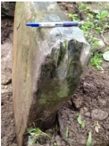
圖 12-13 有肩立石底部一角 可見打石的石楔凹槽
