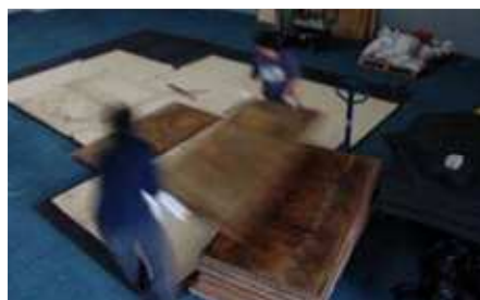
組裝前日派請工人地板鋪設夾板，避免地板損傷
