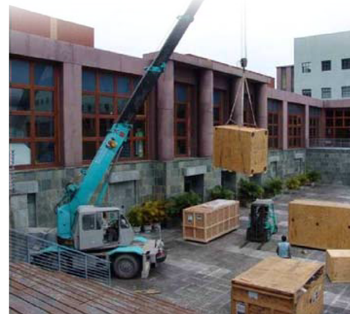
木箱利用吊車吊至二樓迴廊
