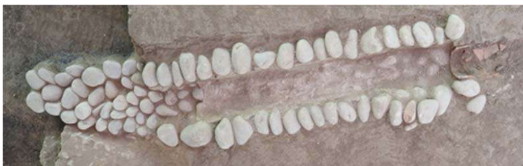
圖 8 礫石水溝、排水礫石鋪面(左)及殘留陶水管(右)
